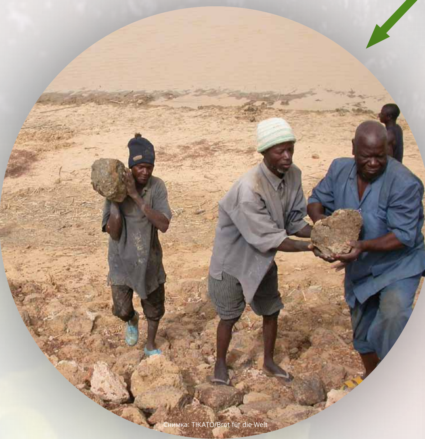
Изграждане на язовир за подобряване на напояването.
