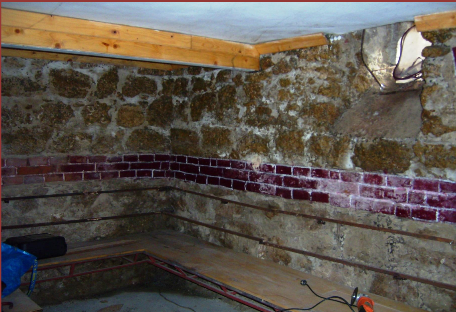
Избата преди ремонта стана склад, съблекалня и санитарно помещение
