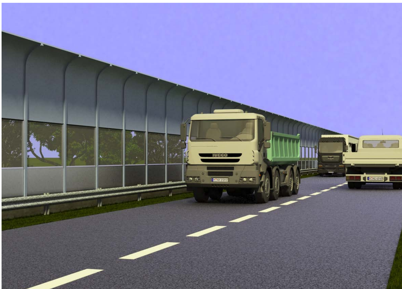
Фиг. 7.10 3-D визуализация от конкретен реализиран от СПЕКТРИ ЕООД проект за изграждане на противошумови бариери (предвидени като типово решение за описаните по-горе мерки с ИД № В12, В3, В6, В78, М2, М3)
